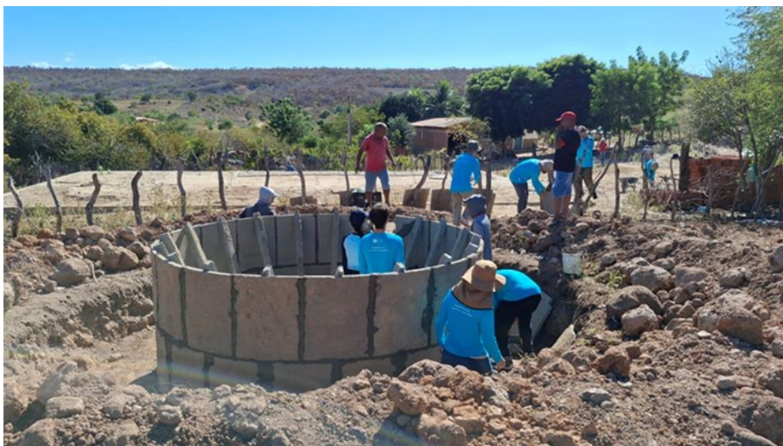
Construção da cisterna
