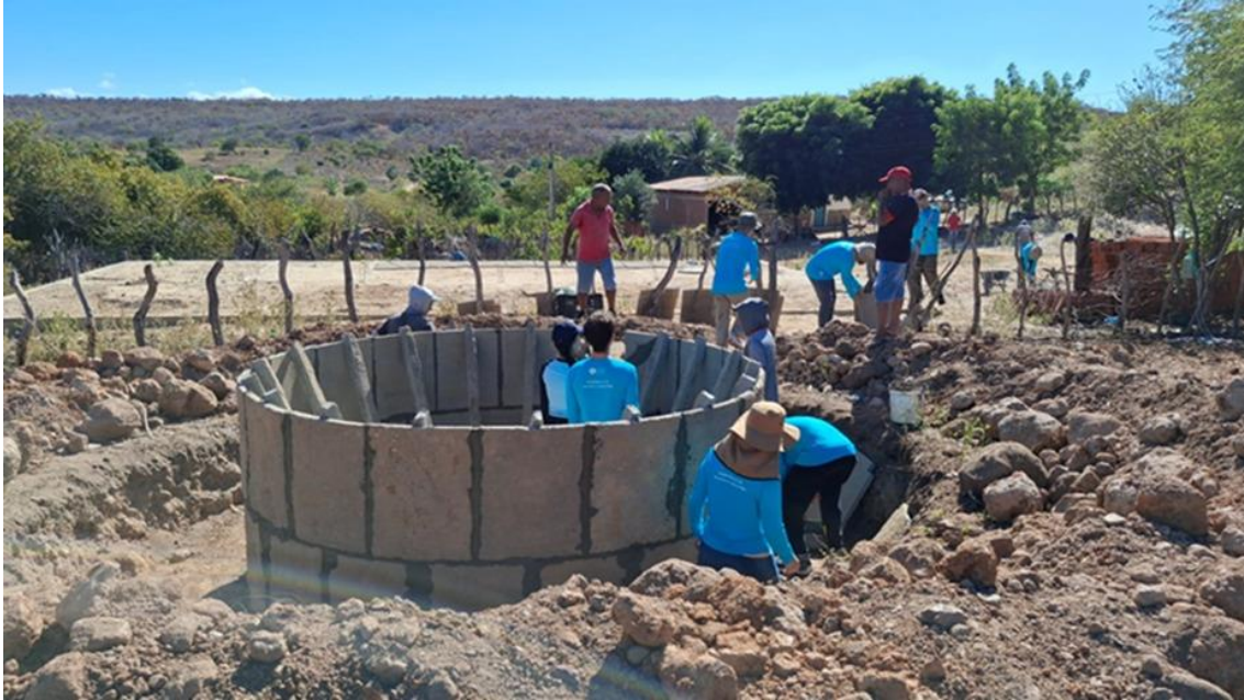
Construction d'une citerne
